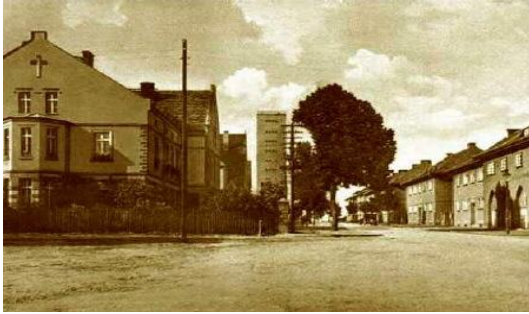
Rysunek 3. Ulica Oleska około roku 1936. Po lewej budynek szpitala w Dobrodzieniu.
